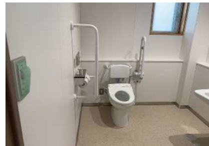
多目的トイレ
